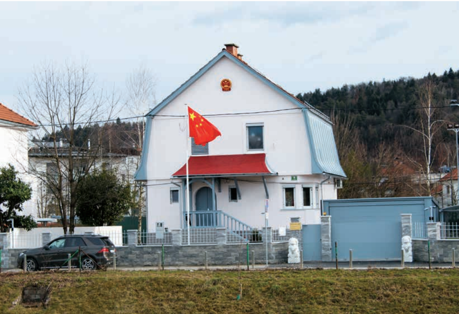
新馆区正门。 Glavni vhod v nove prostore.
